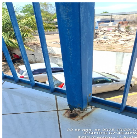
Figura 4: Base da coluna de concreto rachada
