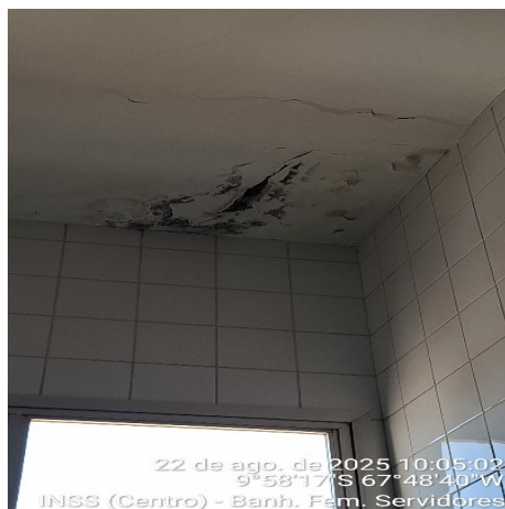
Figura 20: Banheiro fem. servidores
