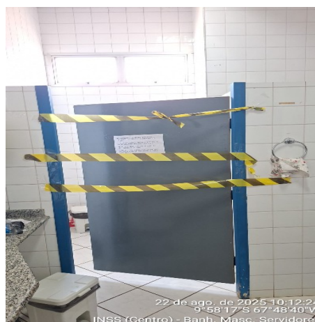
Figura 21: Banheiro masc. servidores
